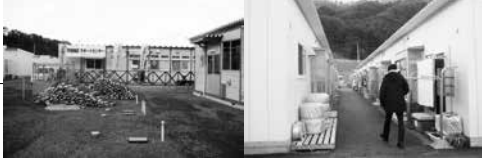
平田の仮設住宅 (2011.12.10)
